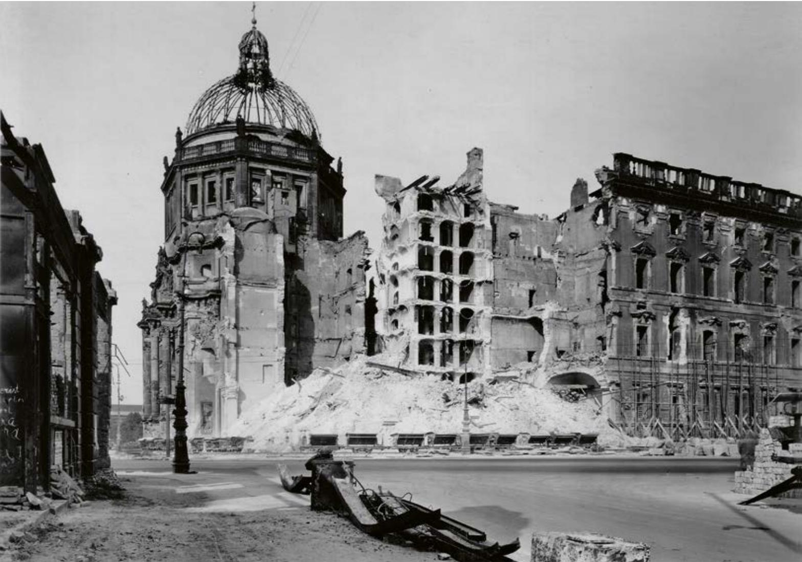
Das gleiche Motiv 1950: Die Sprengarbeiten wurden begonnen. Vor der gesprengten Fassade steht die Kipplorenbahn, mit der der Trümmerschutt abgefahren wurde.
